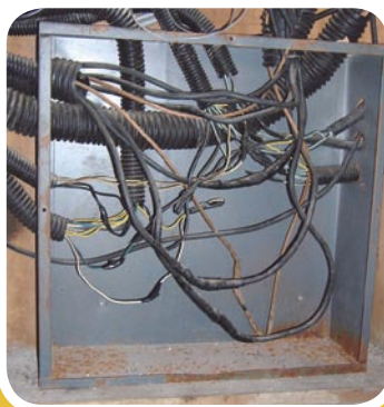
NORMA Exemplo de instalações elétricas que trazem riscos para residências e prédios (à esquerda e meio) e instalação bem-feita (à direita)
